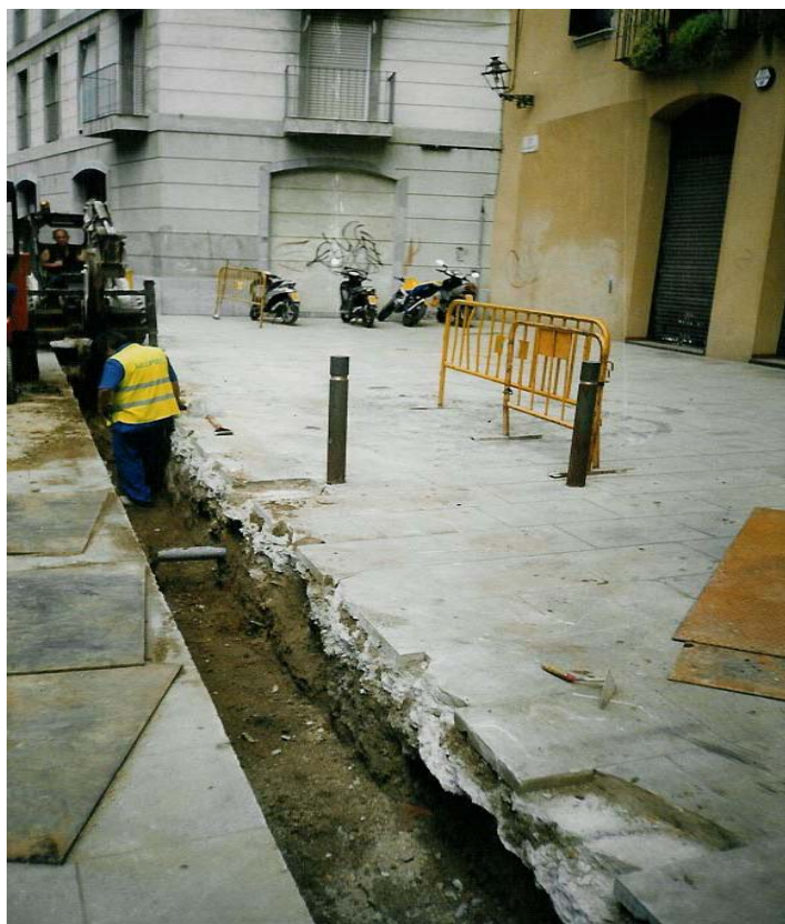
• F10. Rasa 7000. C/ d'en Tantarantana. Buidant rasa amb màquina.
