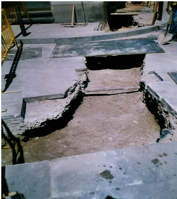
F9. Rasa 7000. C/ d'en Tantarantana. Enllaç amb la rasa 6000 a la cantonada amb el C/ de la Princesa.
